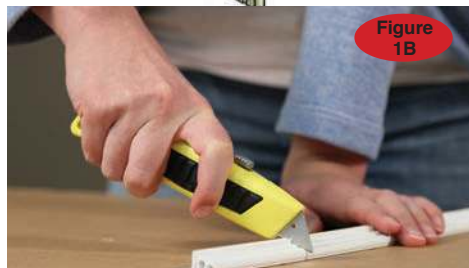
1B Couper la base Miracle Fit avec une scie ou un couteau pour qu'elle entre dans la hauteur de la fenêtre (Voir figure 1A de A-B).
