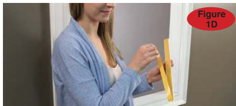
1D Enlever le ruban à deux côtés derrière la base Miracle Fit.
