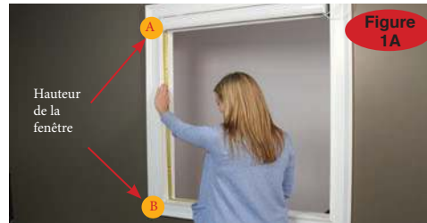
1A Mesurer la hauteur de la fenêtre (A-B).
